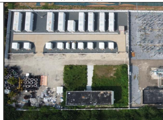
站址西侧现状
