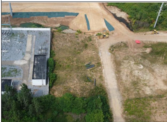
站址东侧现状
