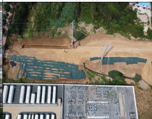
站址北侧现状
