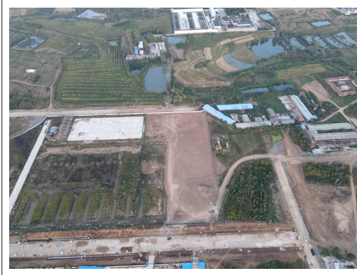
厂区西侧现状
