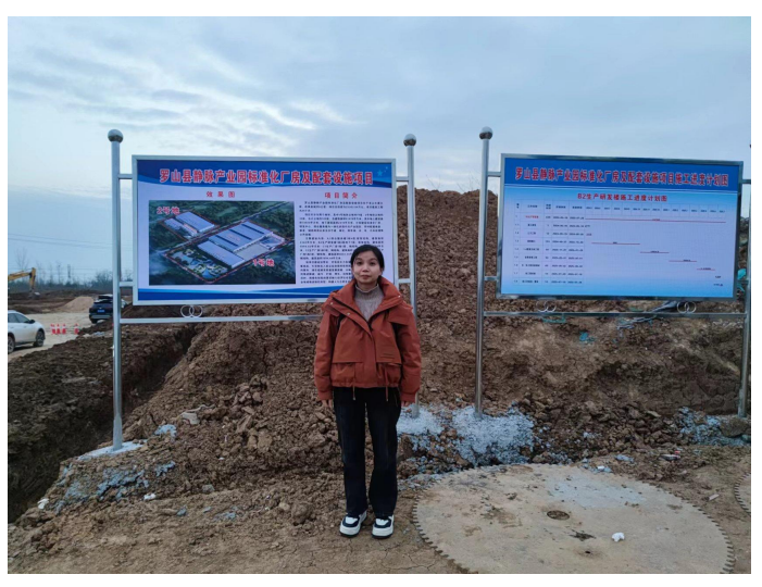
工程师现场踏勘照片
