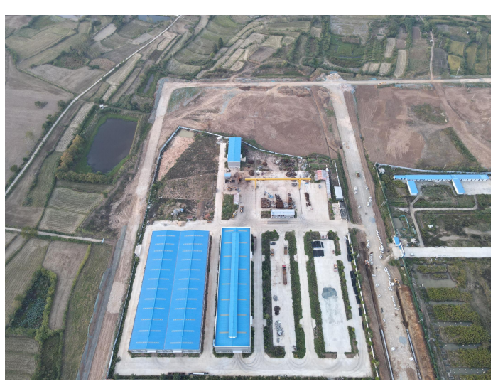
厂区北侧现状
