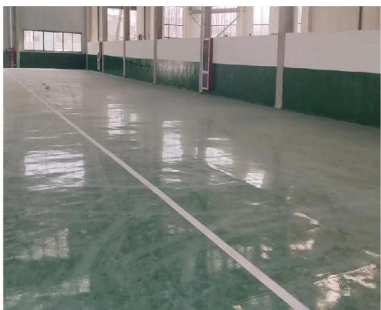
废铅蓄电池贮存车间
