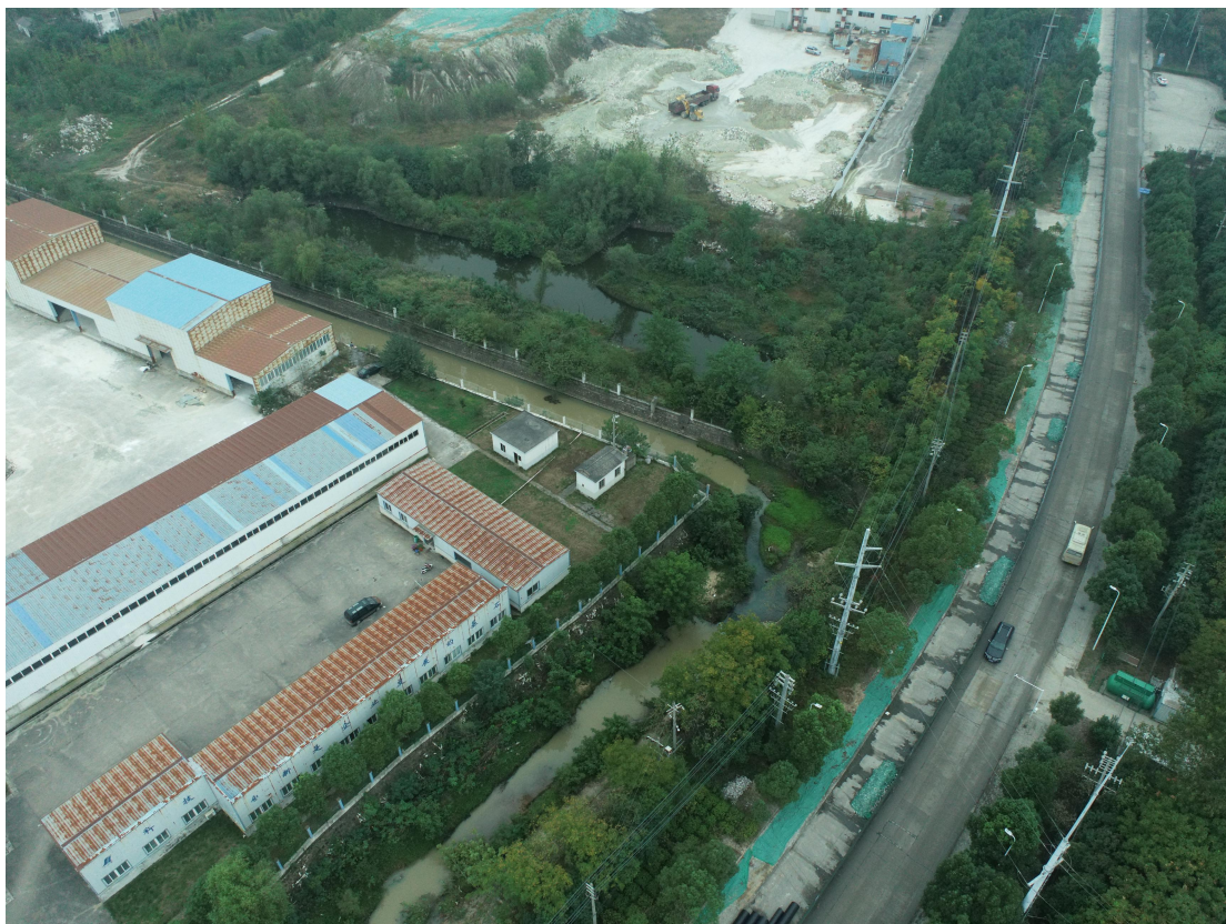
在建市政工程
