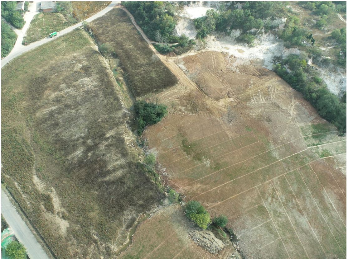
在建工程表土剥离
