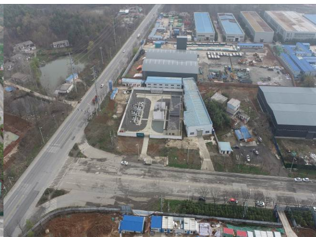
邓庙 110kv 变电站
