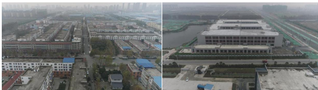
图 3.5-3 已建区水土保持设施现状
