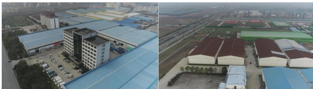
图 3.5-2 已建区水土保持设施现状
