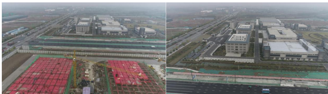
图 3.5-1 在建区域水土保持设施现状
