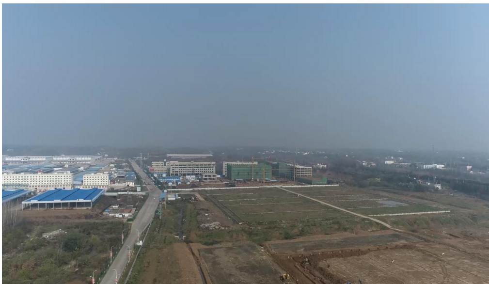
图 3-2 已建成的工业工程部分水土保持设施现状
