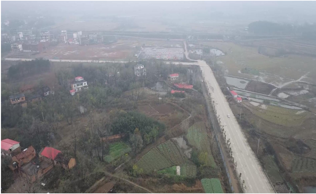
图 3-4 已建成道路水土保持设施现状
