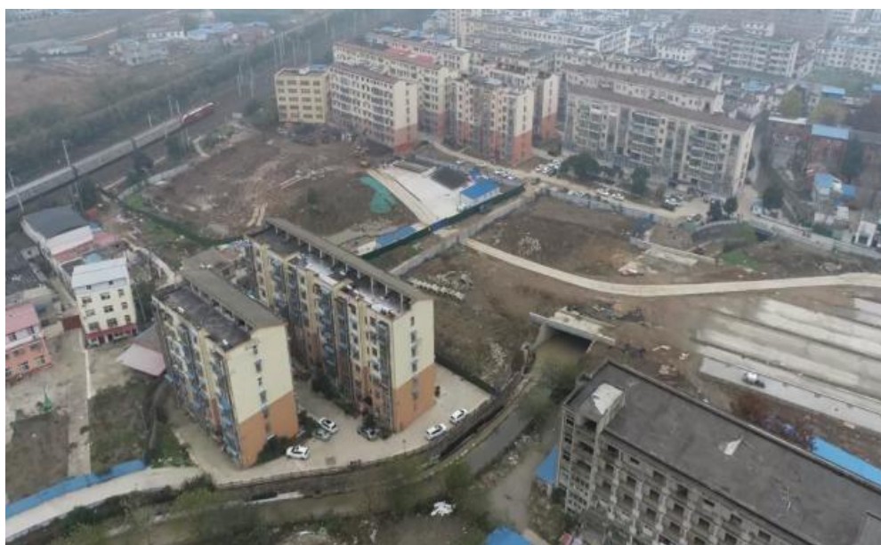
图 3-3 在建住宅项目部分水土保持设施现状
