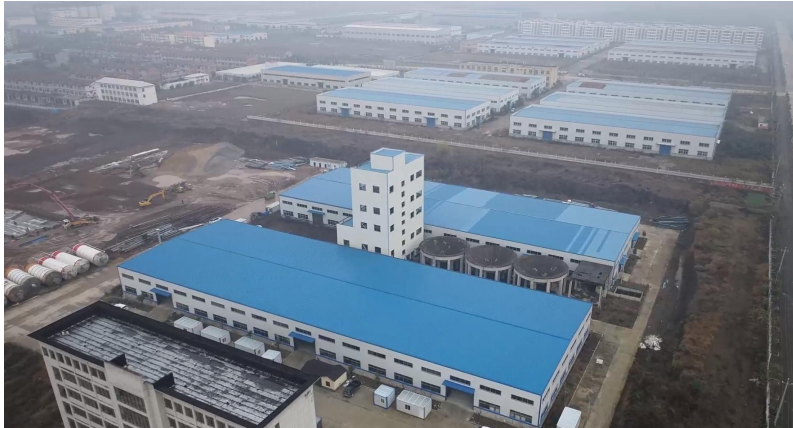
图 3.5-1 已建成部分企业水土保持设施现状
