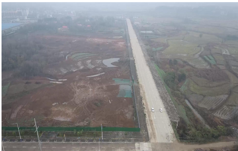
图 3.5-2 在建住宅项目部分水土保持设施现状
