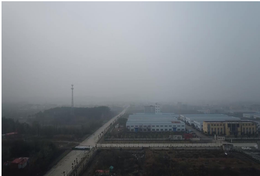
图 3.5-3 已建成道路水土保持设施现状
