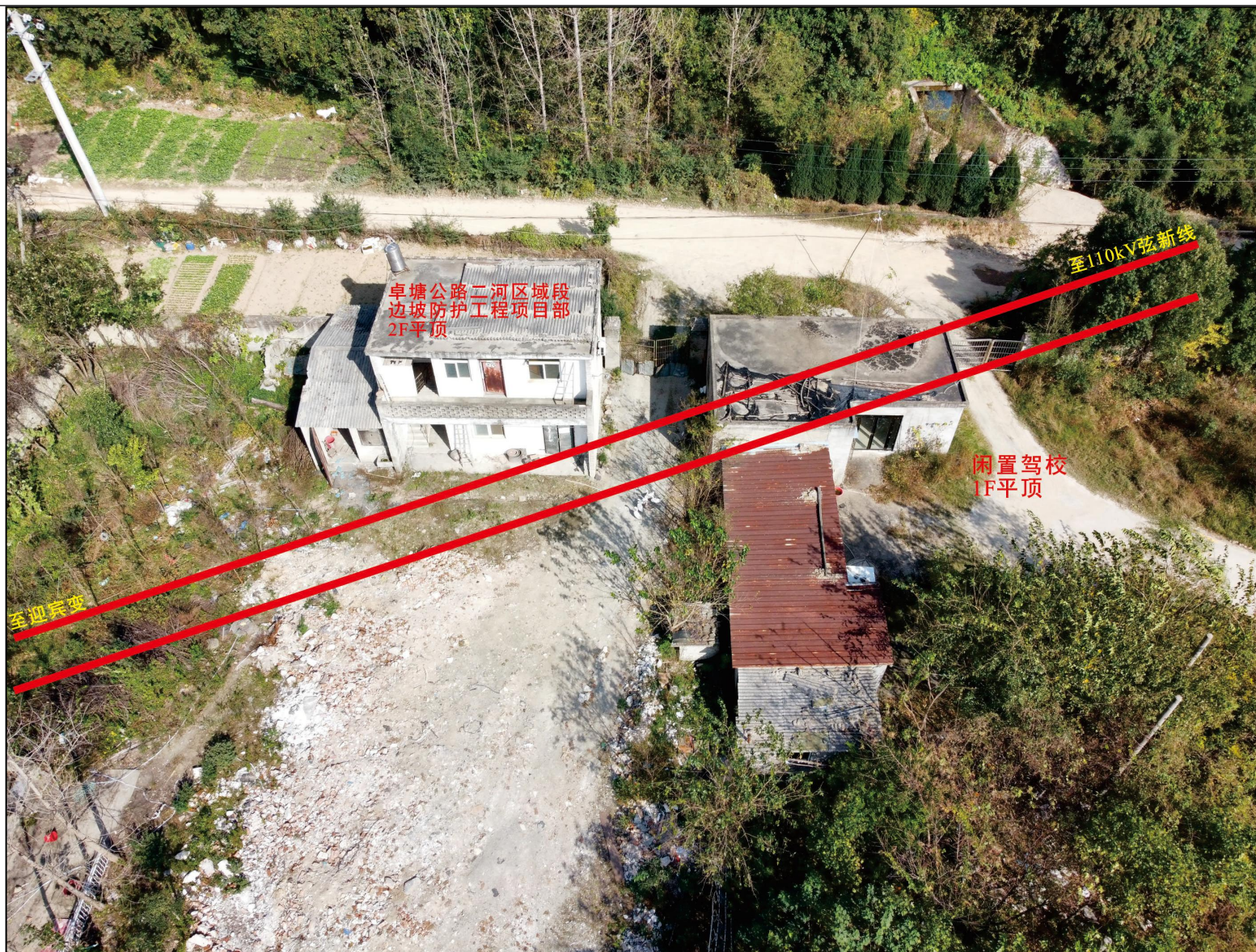
图 3-4 本项目变电站及输电线路评价范围内环境敏感目标现状照片
