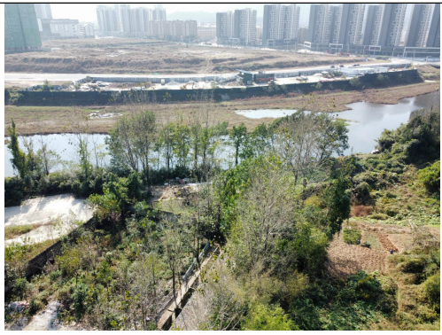
变电站南侧潢河现状照片
