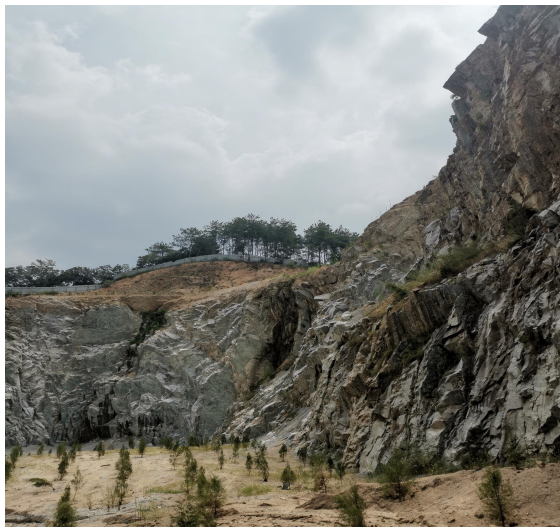
照片 4-5 YH2 隐患点节理、裂隙发育面
