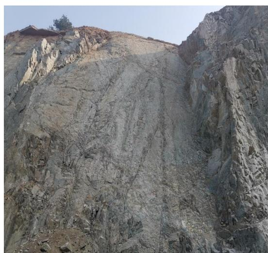
照片1-6 YH3隐患点裂隙发育面
