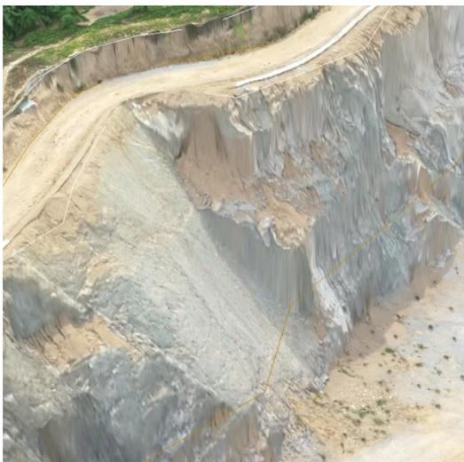
照片1-5 YH2隐患点节理、裂隙发育面
