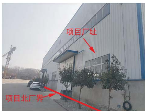
项目北厂界现状
