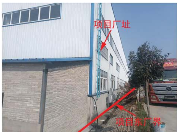
项目东厂界现状
