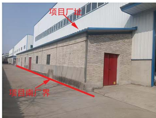
项目南厂界现状
