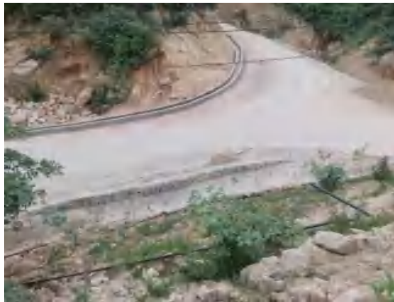
采区外运矿道路现状（硬化路面）
