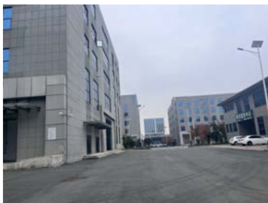
项目厂址西侧
