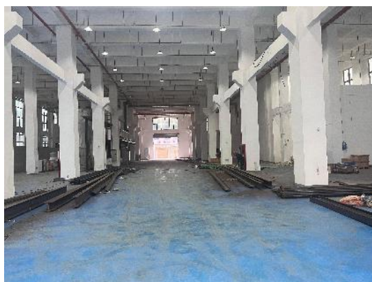
项目一楼厂房内部
