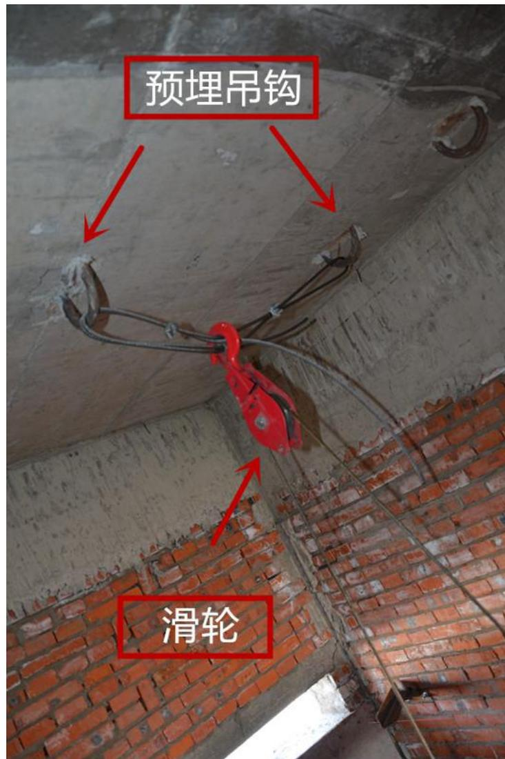
电梯井道 10 楼地坎到井道顶部高度为 4.5m，卷扬机钢丝绳到井道顶部距离约 1m，卷扬机上下运行时卷扬机滑轮固定的钢丝绳与预埋吊钩摩擦，因预埋螺纹钢与钢丝绳材料不
