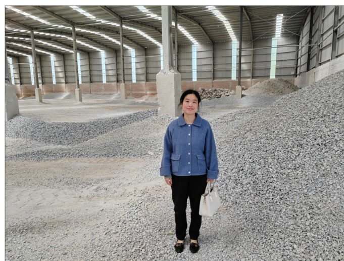
工程师现场踏勘
