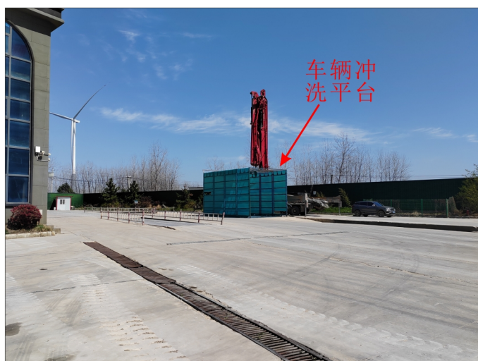
本项目北侧外车辆冲洗平台
