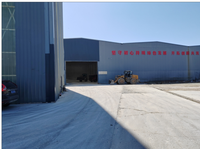
项目所在地厂房现状
