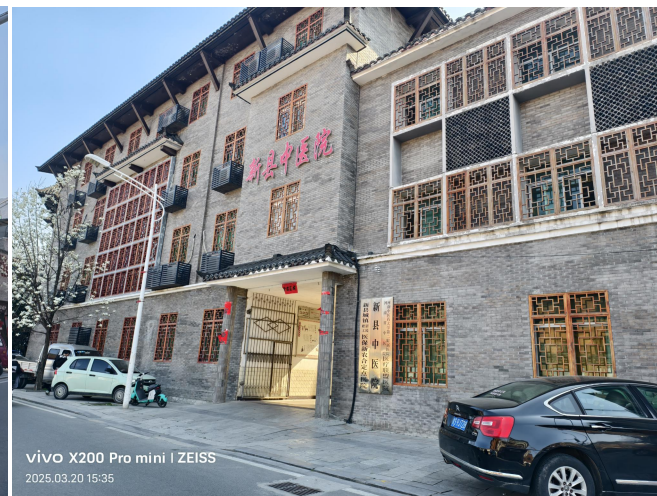
北侧新县中医院老院区
