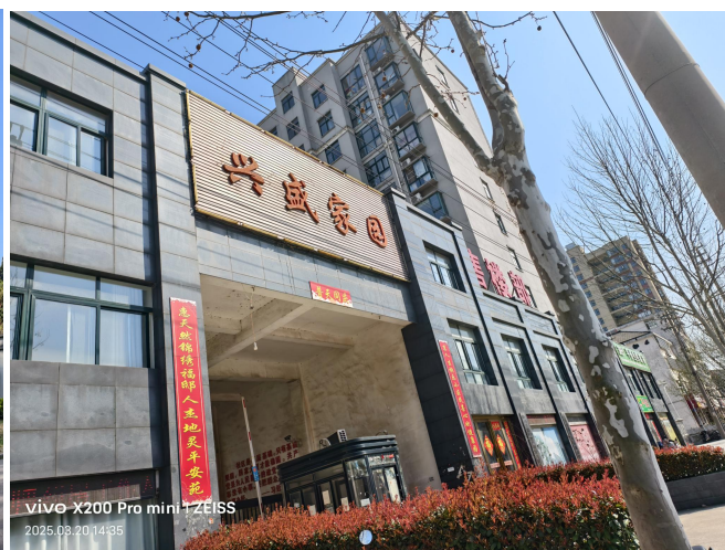
南侧兴盛家园
