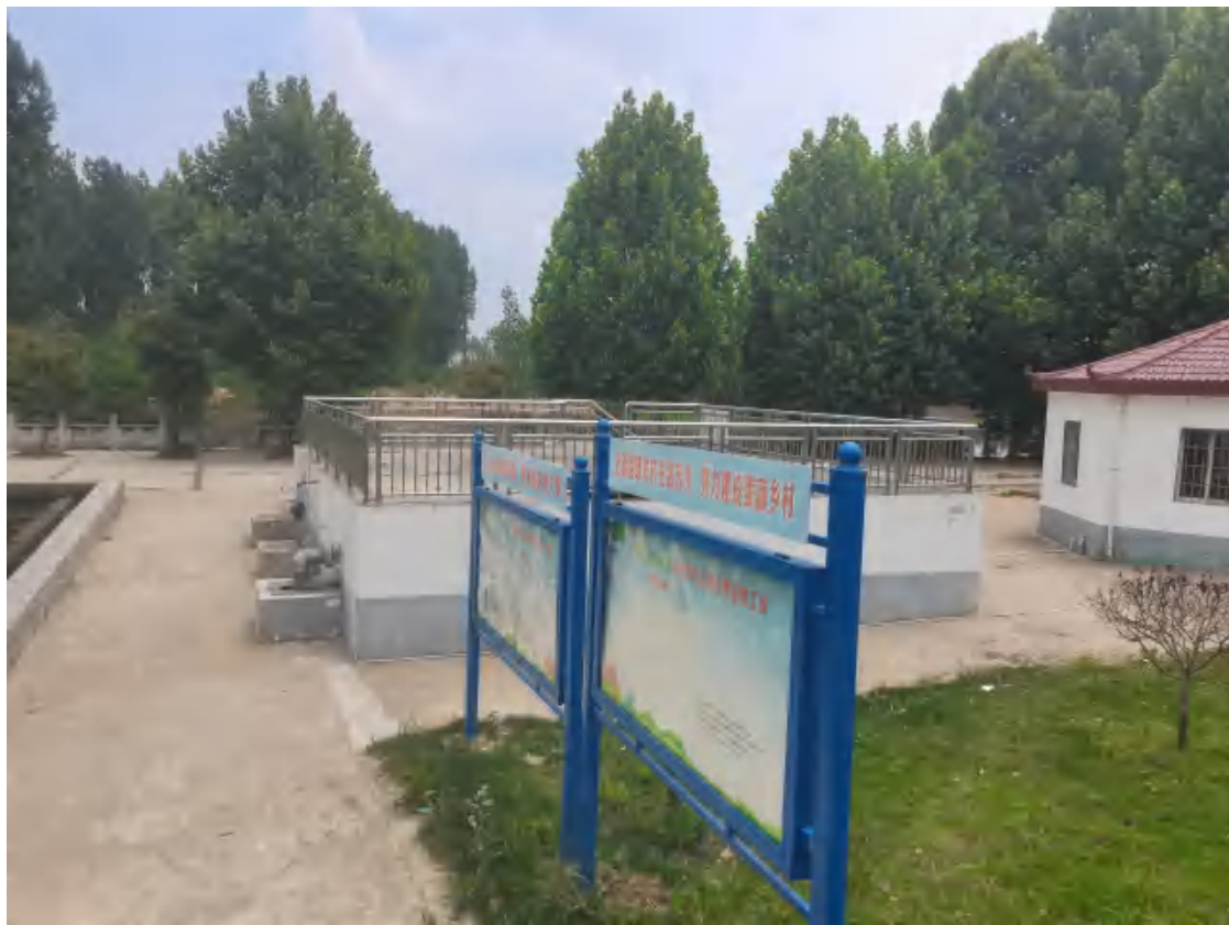
楠杆镇污水站 1 号现状
