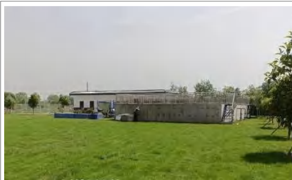
竹竿镇污水站
