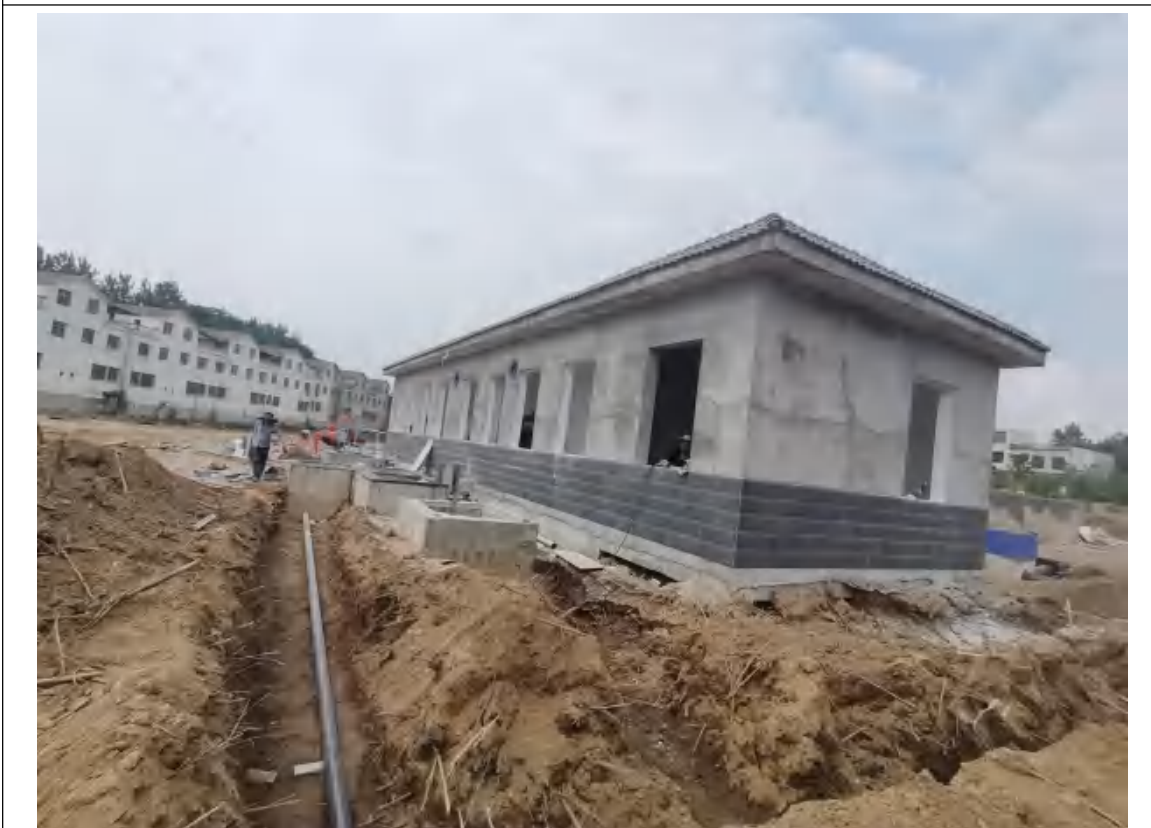
定远乡污水站现状
