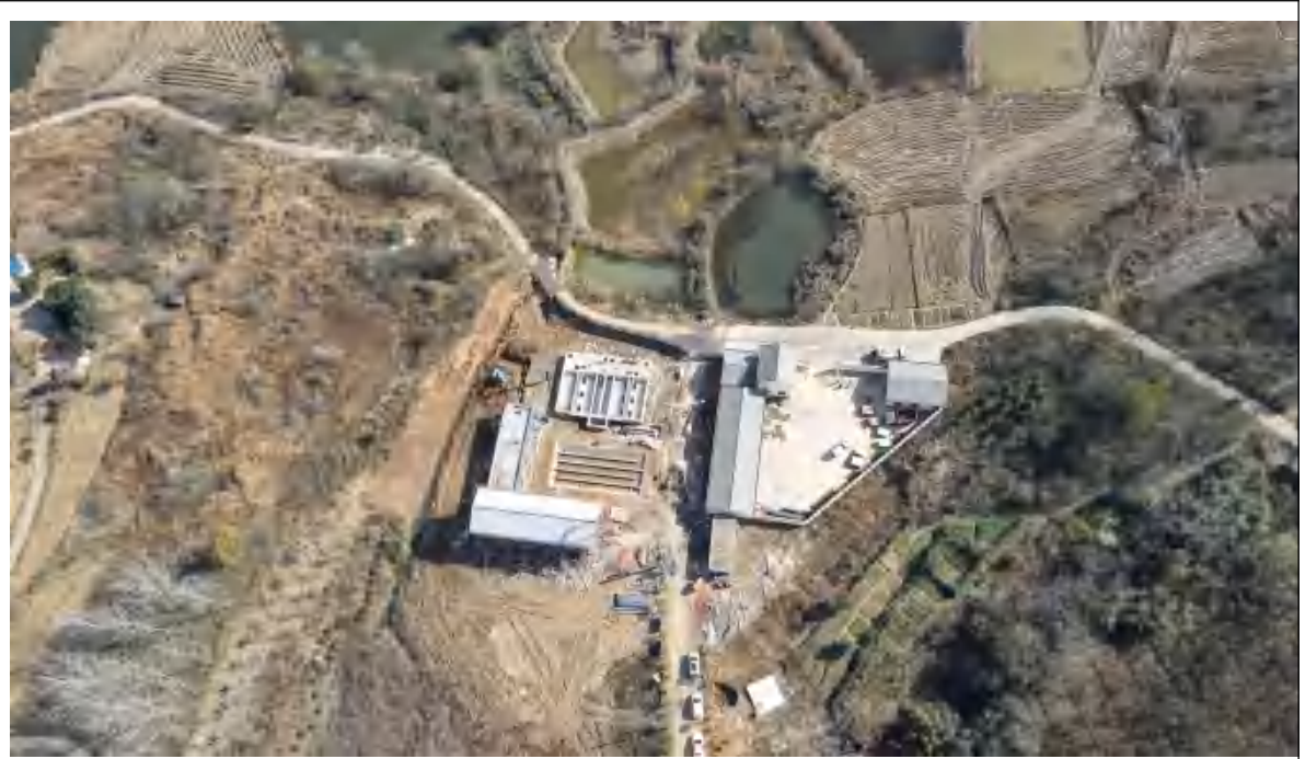
莽张镇东污水站现状
