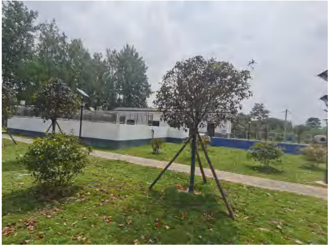
高店乡污水站现状
