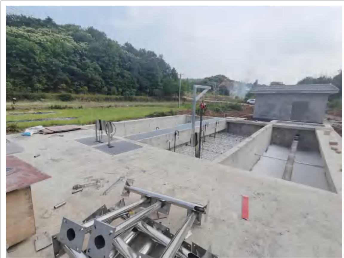
山店乡污水站项目现状
