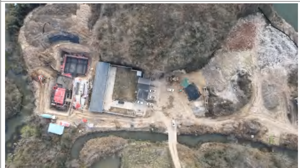
青山镇污水站现状
