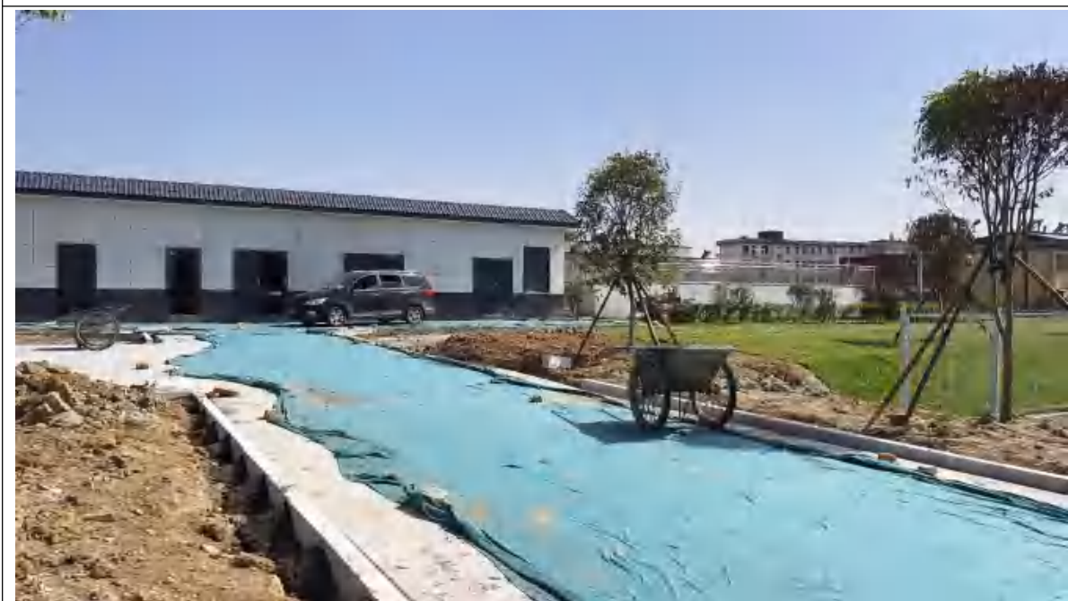
东铺镇污水站现状
