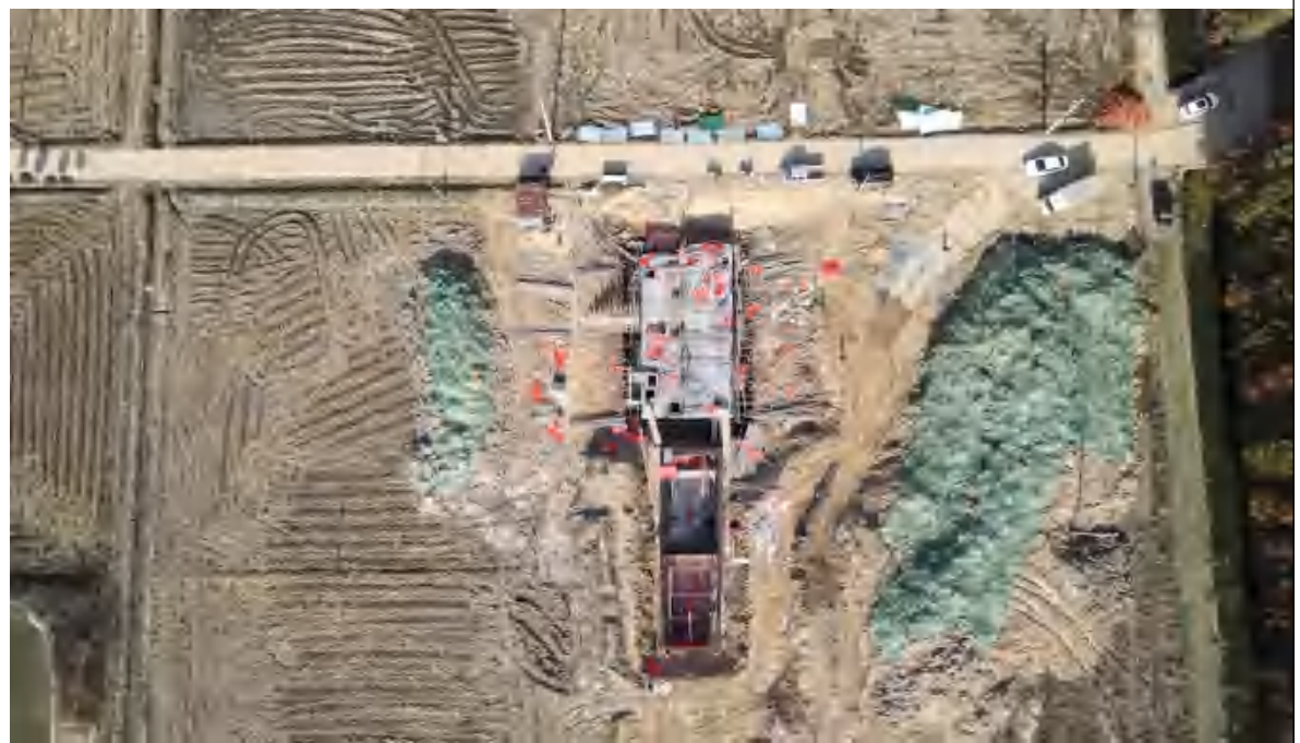
子路镇污水站现状
