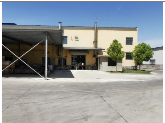
租赁厂房北侧的锅炉房
