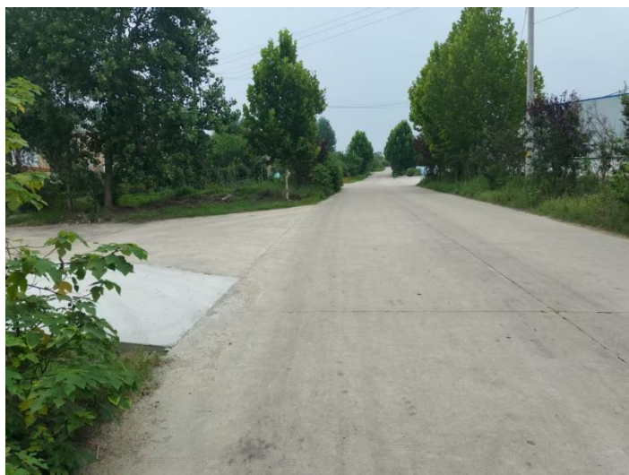
项目北侧老信潢路
