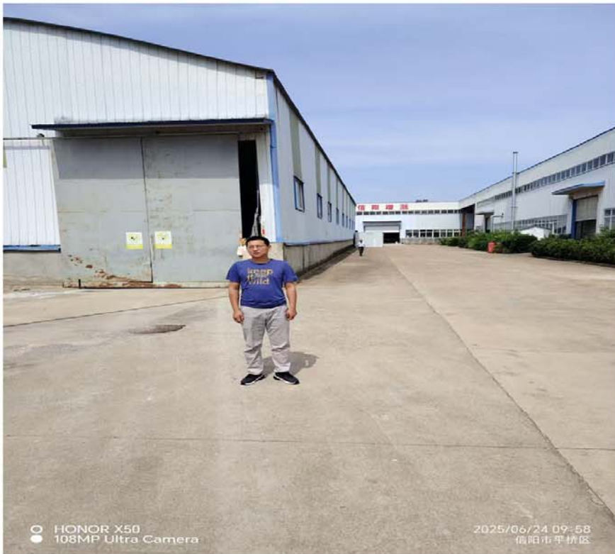
工程师现场踏勘
