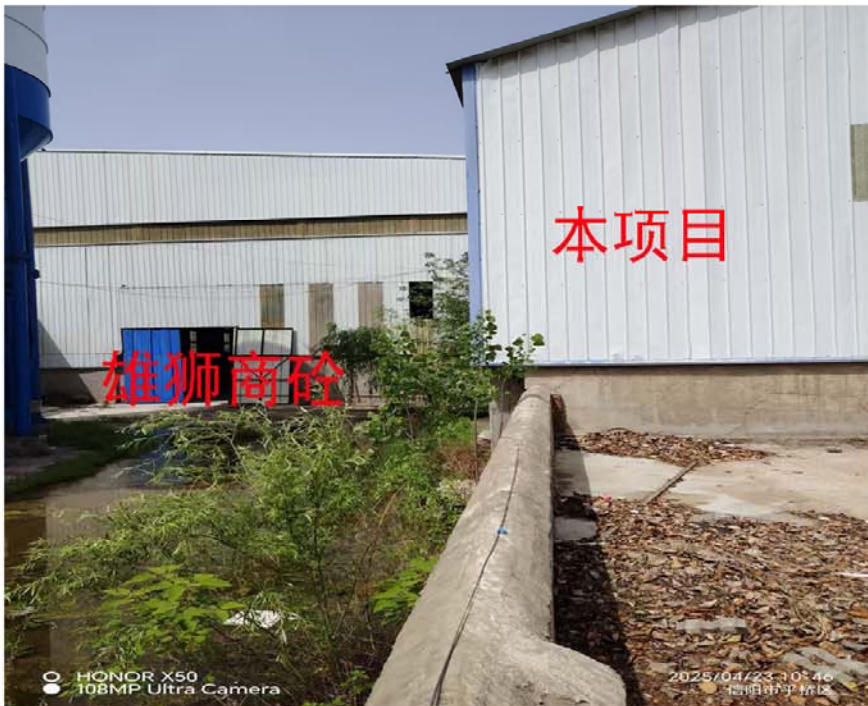
项目南侧现状
