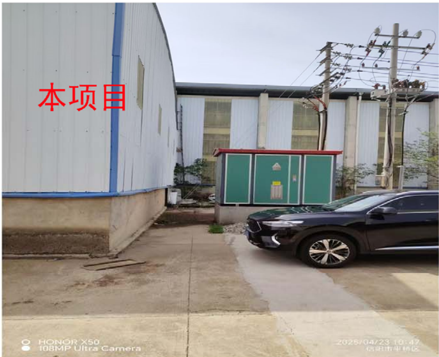
项目西侧现状
