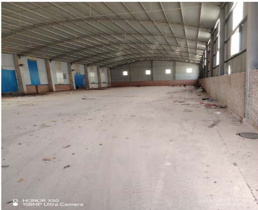
厂房内部现状
