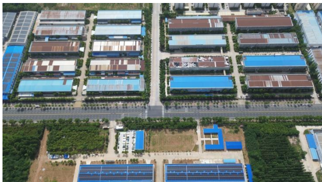
项目西侧（德隆生产车间、天杨光电）
