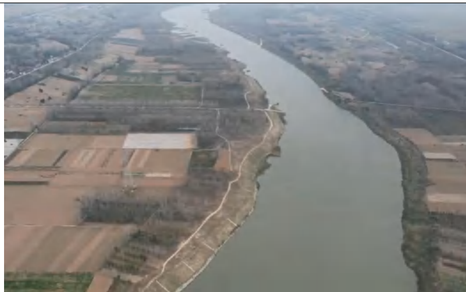
豫东南枢纽工程选址航拍图
