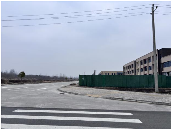
项目南侧（园区道路）
