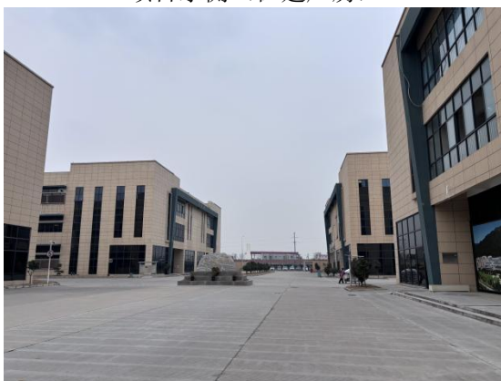
生产厂区现状
