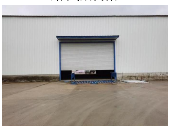
车辆冲洗设施
