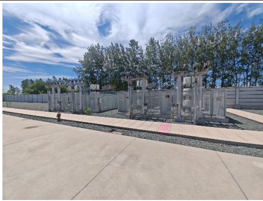
厂内道路硬化
