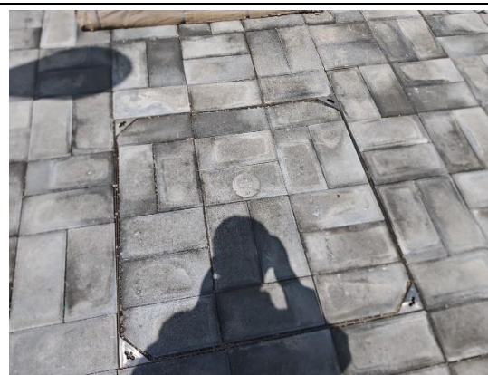
站内现有的化粪池
