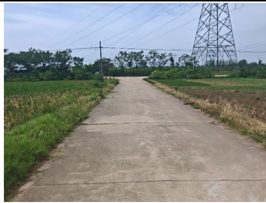
进站道路硬化
