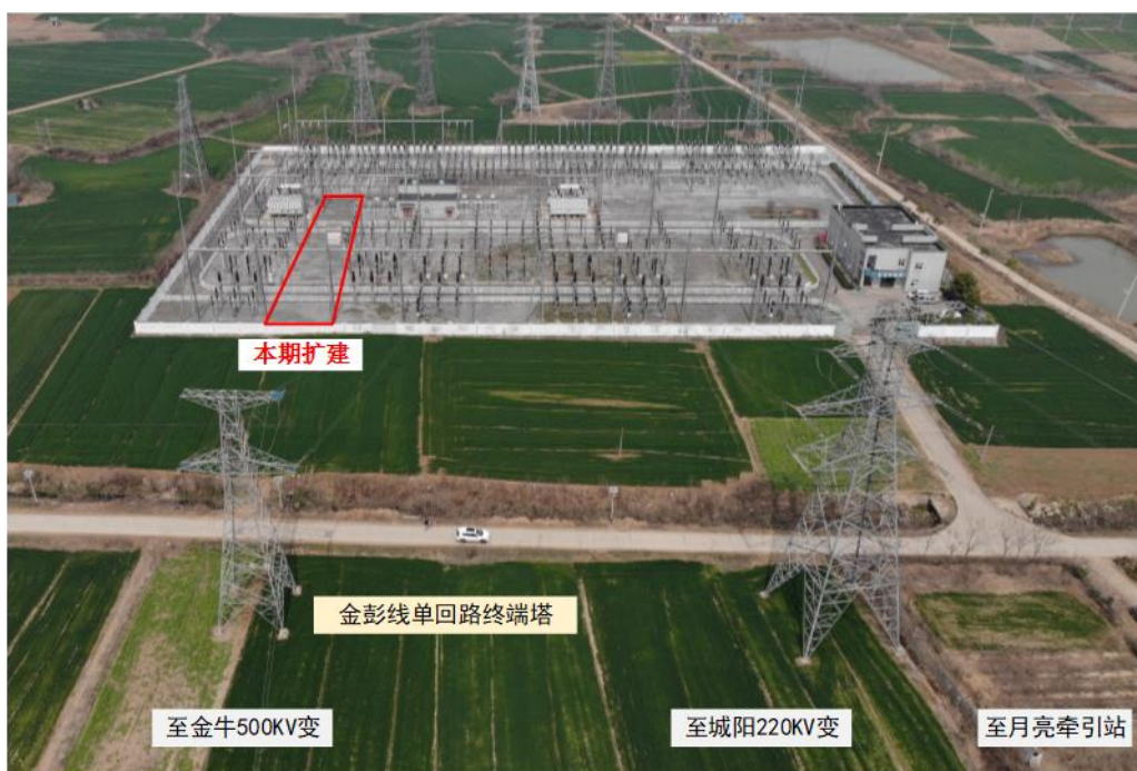
图 6 本期彭庄变 220kV 出线间隔扩建航拍图
