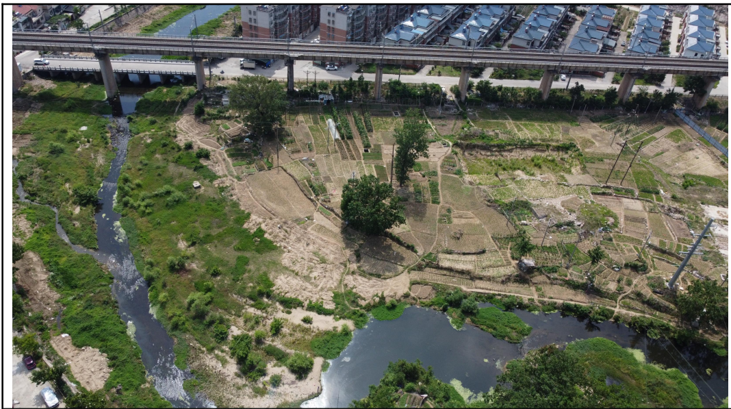
变电站东南侧
