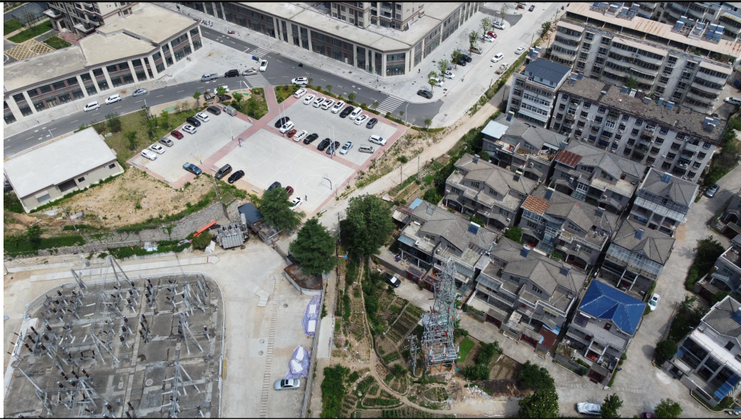
变电站东北侧、西北侧
