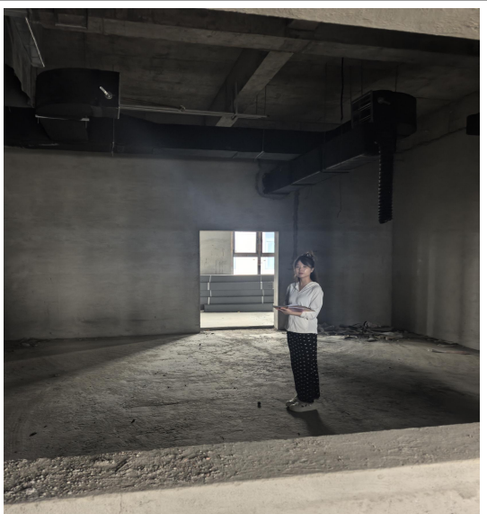
拟建DSA1号手术室现状照片
