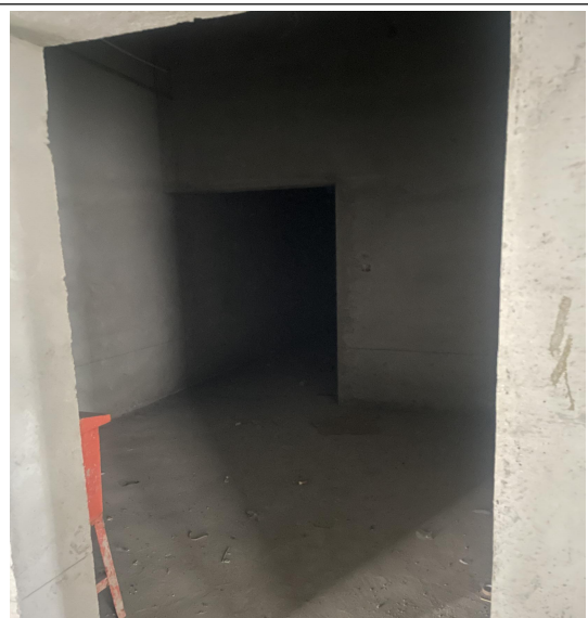
拟建DSA1号手术室西侧设备间
