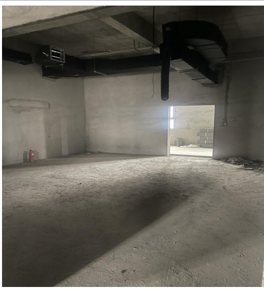
拟建DSA2号手术室现状照片
