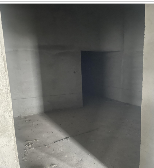
拟建DSA2号手术室东侧铅衣存放间
