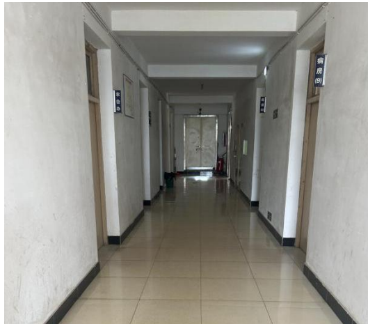
卫生院内住院综合楼内部现状
