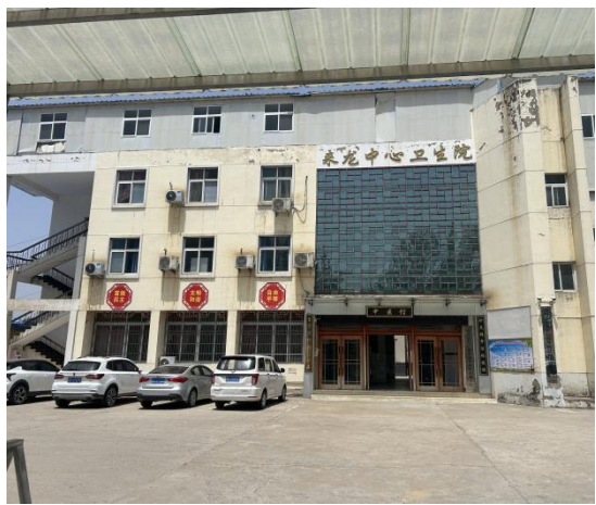
卫生院内门诊综合楼现状
