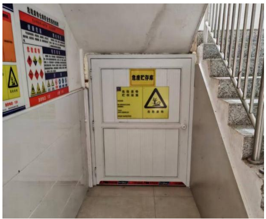
项目已建危废贮存库现状
