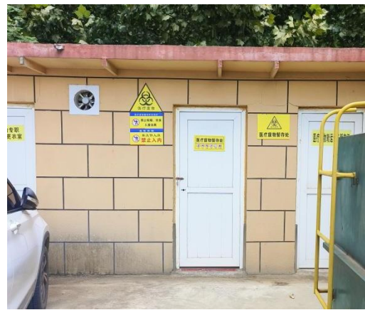
项目已建医疗废物暂存间现状
