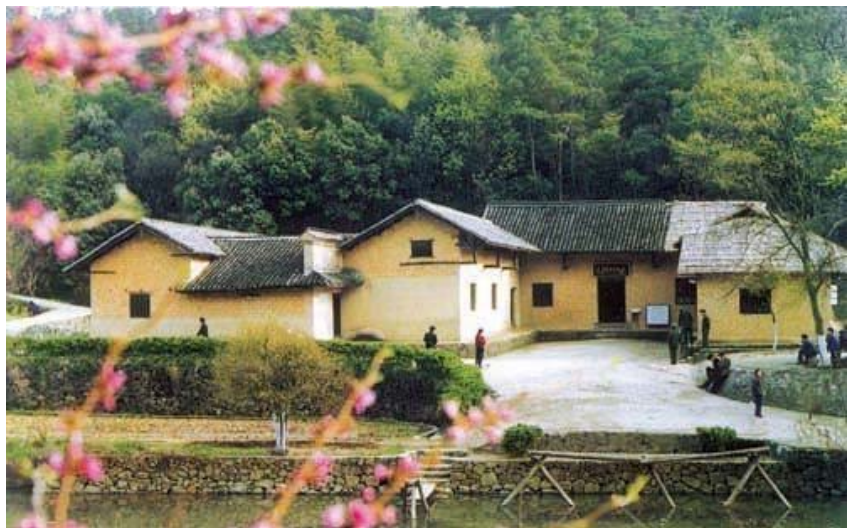
故居房屋提升
