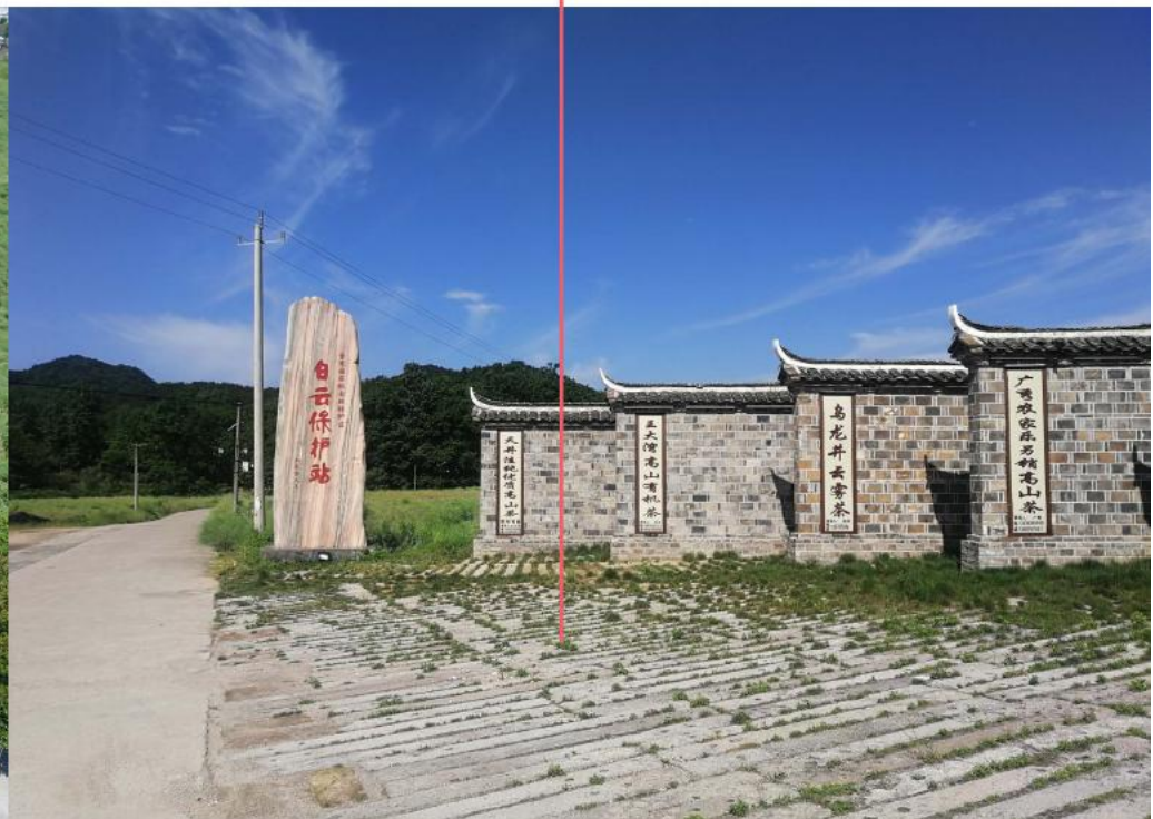
场地铺装老化破旧
