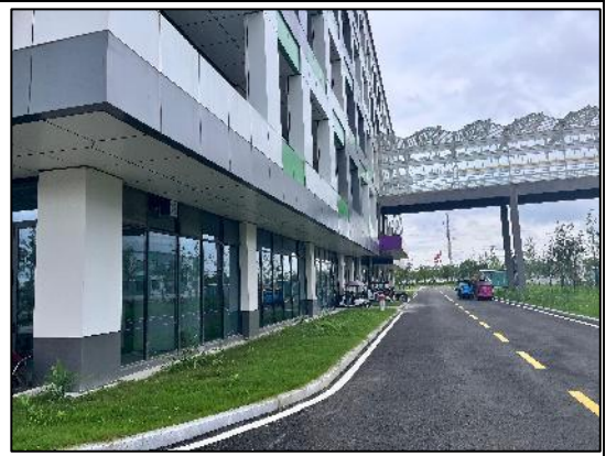
项目厂区西侧
