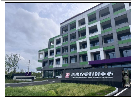
项目所在厂区东侧大门
