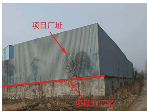
项目北厂界现状
