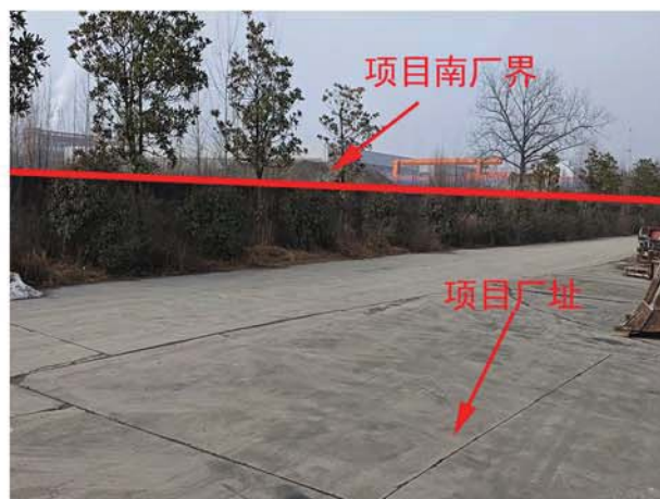
项目南厂界现状
