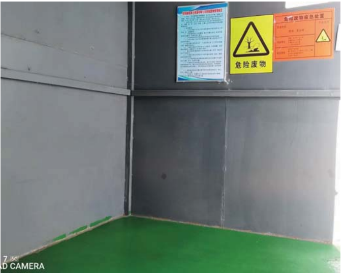
厂区危废暂存间现状
