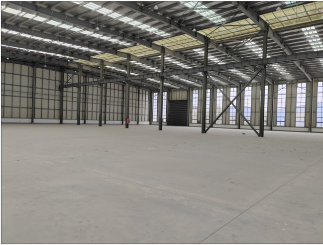
项目厂房内部现状
