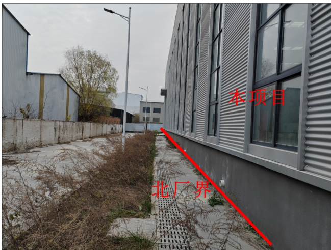
项目北厂界现状
