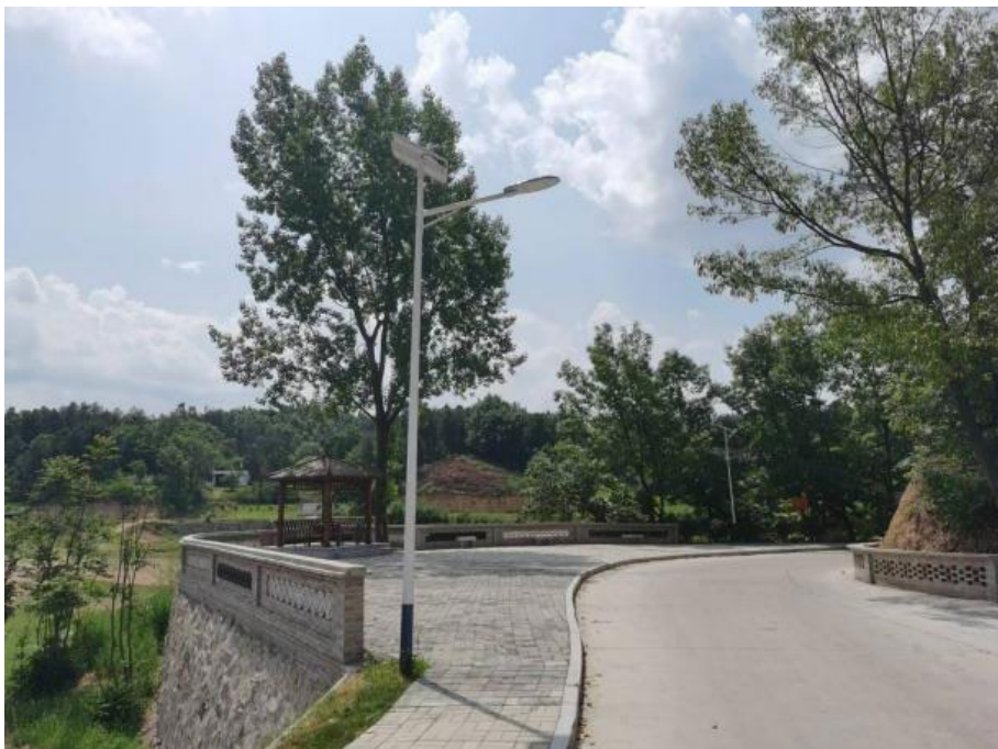
紫云山停车场、道路、路灯项目
