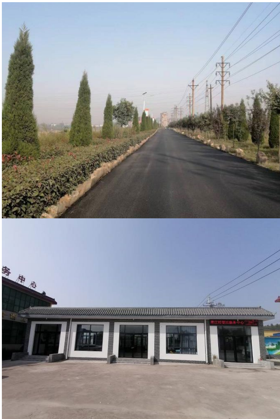
蒋庄村新建柏油路及便民服务大厅
