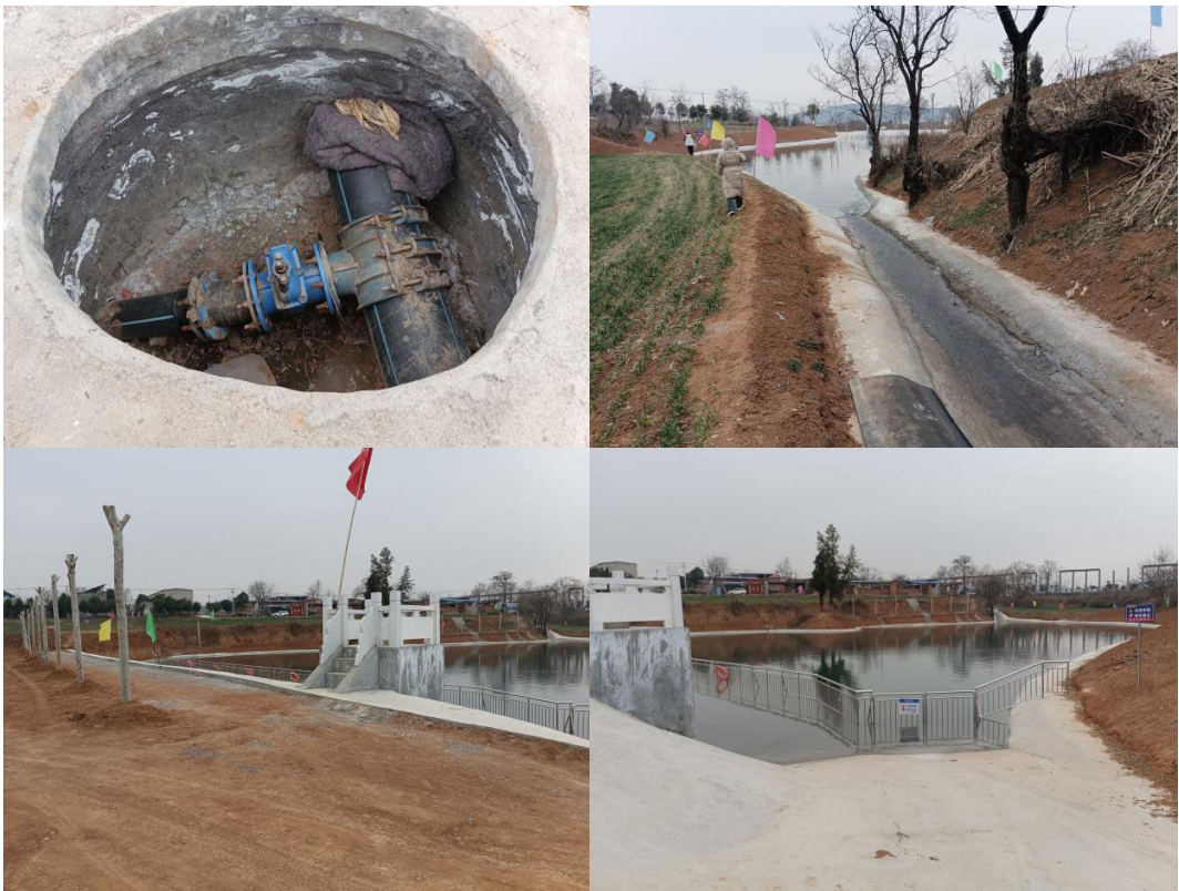
引水渠及坑塘
