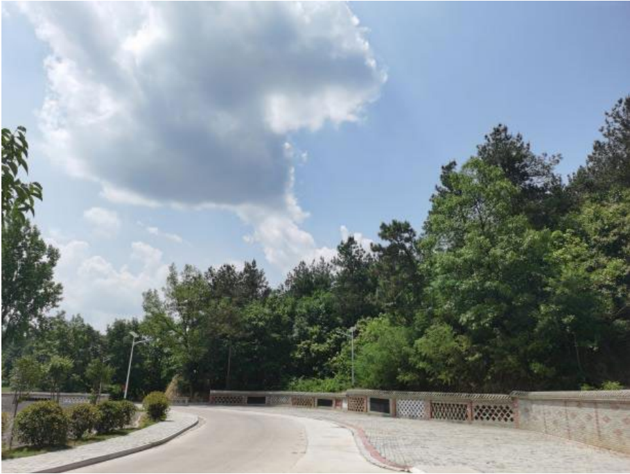
紫云山停车场、道路项目
