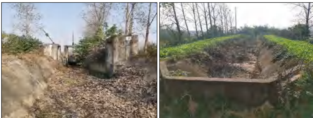
图 2.2-9 单台灌区渠道及渠系建筑物现状照片
