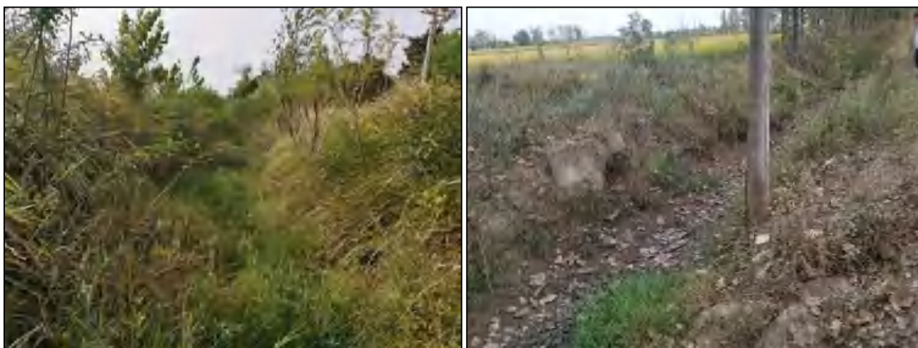
图 2.2-5 任大寨干渠与支渠土渠现状照片
