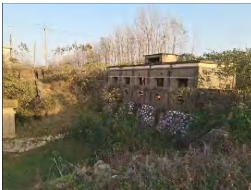
图 2.2-12 洪庄电灌站现状照片
