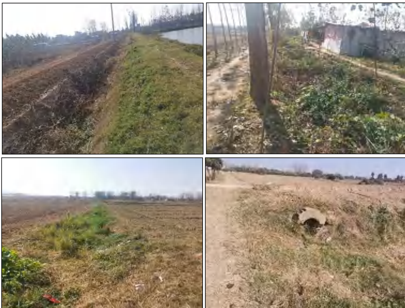
图 2.2-13 洪庄灌区渠系工程及建筑物现状照片
