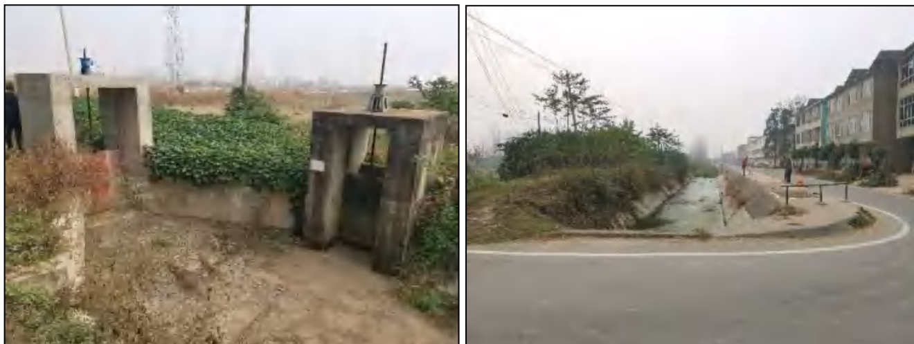
图 2.2-11 临河灌区渠道及渠系建筑物
