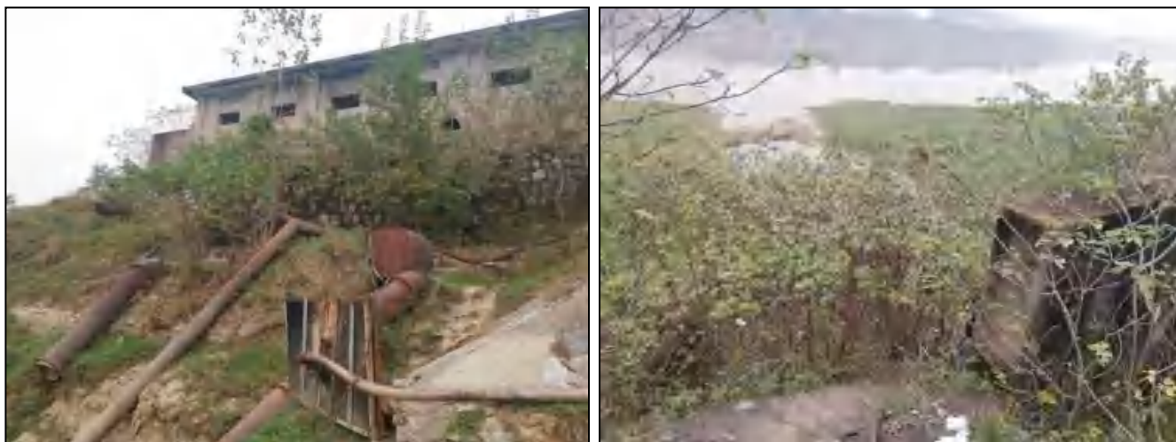
图 2.2-8 单台电灌站现状照片
