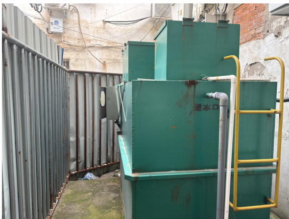
现有污水处理站
