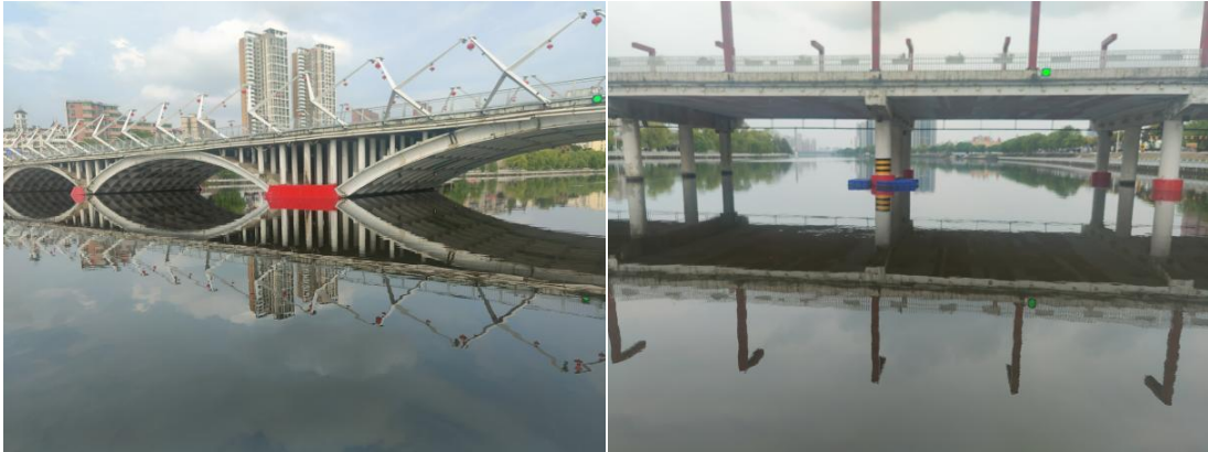
图 2.1-3 桥墩防撞设施图
