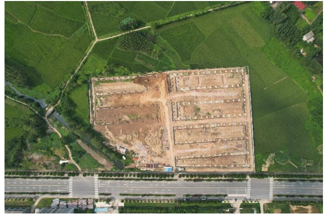
项目地块内现状（航拍）
