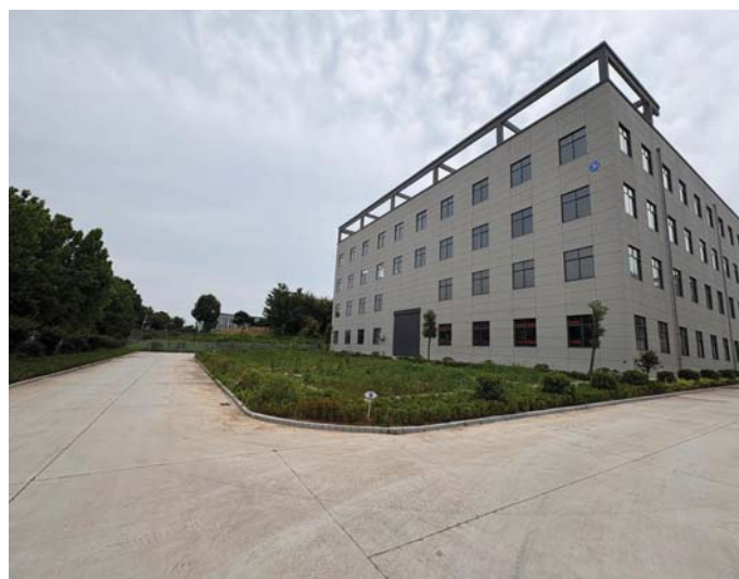
项目车间周边消防通道及绿化带
