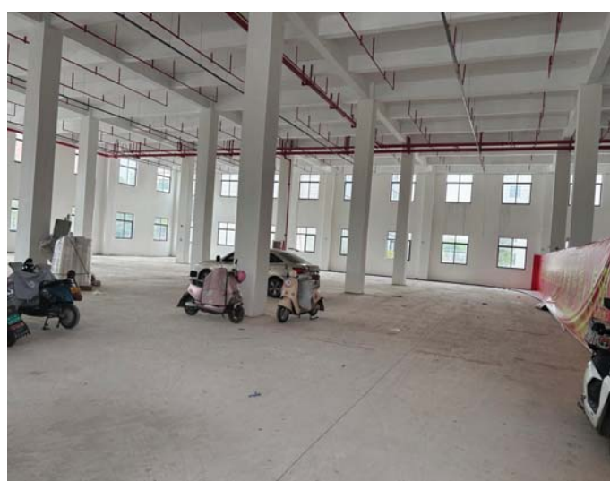
项目车间西侧闲置厂房
