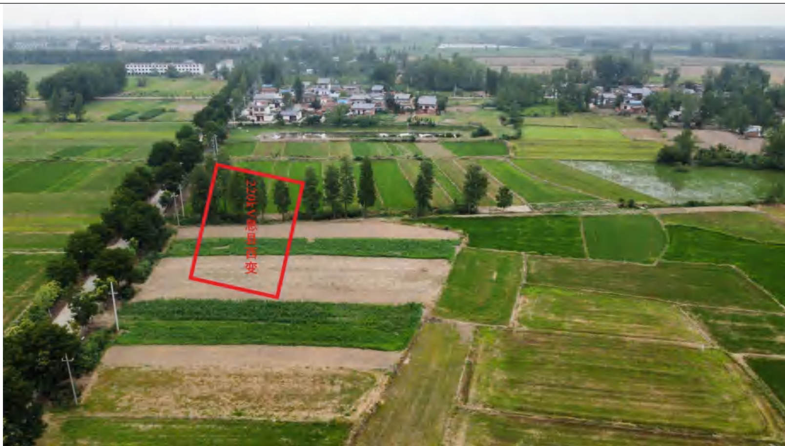
图 3-3.2 息县西 220kV 变电站周边环境现状照片
