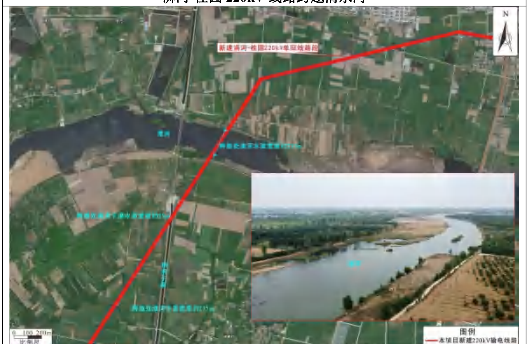
清河-桂园 220kV 线路跨越淮河、南湾干渠
