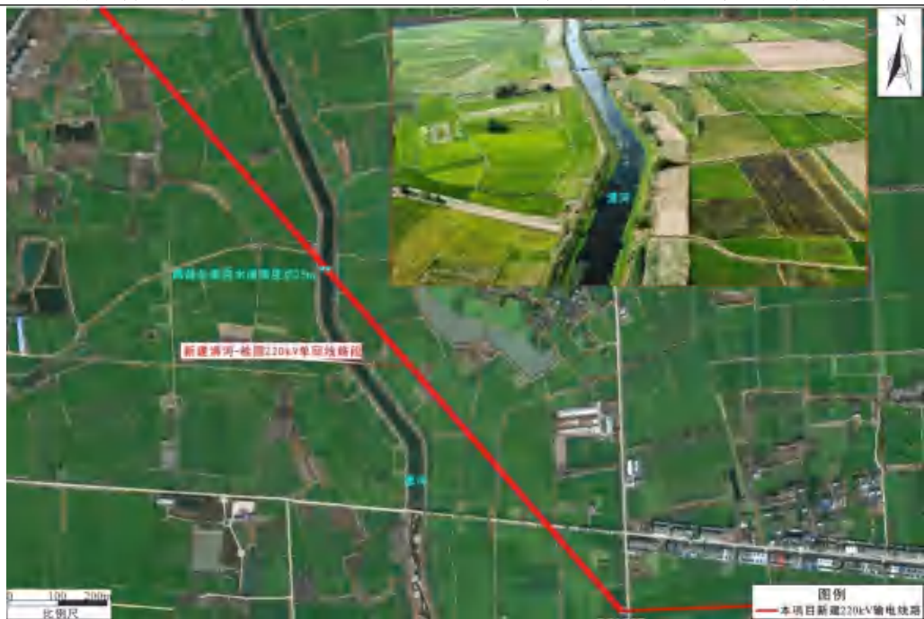
清河-桂园 220kV 线路跨越滢河
