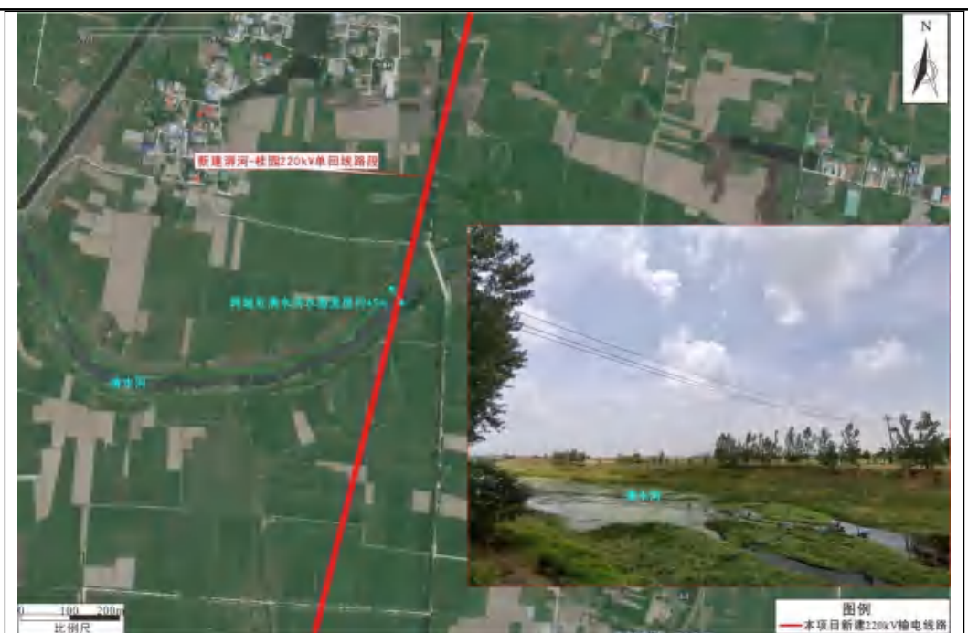
清河-桂园 220kV 线路跨越清水河
