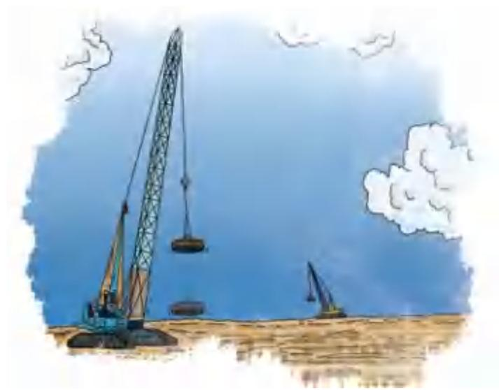
**置换法:**把原地基中的淤泥质土、松散粉细砂层挖去, 用中粗砂、石块、素土填埋并分层夯实。也可采用灰土地基, 常用灰土体积比为2 : 8 或3 : 7。
