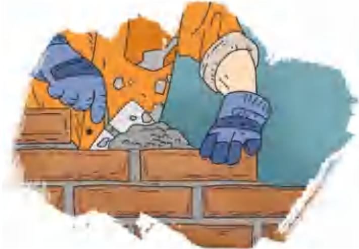
☑ 采用正确的砌筑方法。内、外墙尽量同时砌筑；灰浆要饱满，灰缝厚度应控制在8~12毫米；每层砖必须互相错缝搭接。
